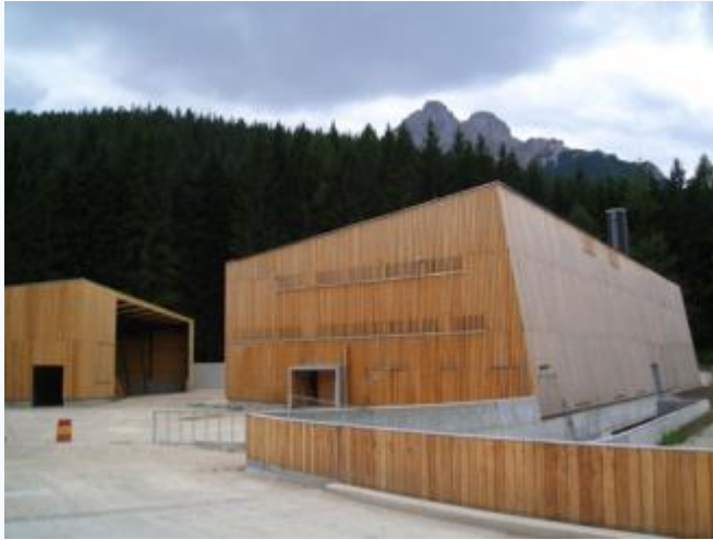
Centrale di teleriscaldamento (17 MWt) di Sesto Pusteria (BZ)
