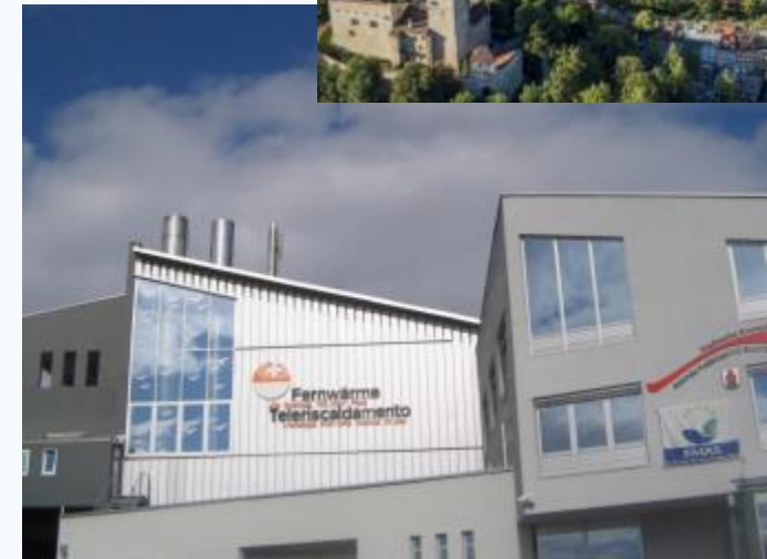
Centrale di teleriscaldamento cogenerativa (30,7 MWt a biomassa + 8,2 MWe ORC) di Brunico (BZ)
